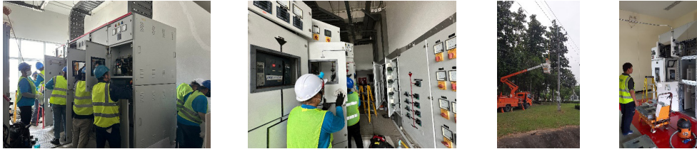
รูปที่ 12 งานบำรุงรักษาเชิงป้องกันระบบไฟฟ้าแรงสูง-แรงต่ำ
